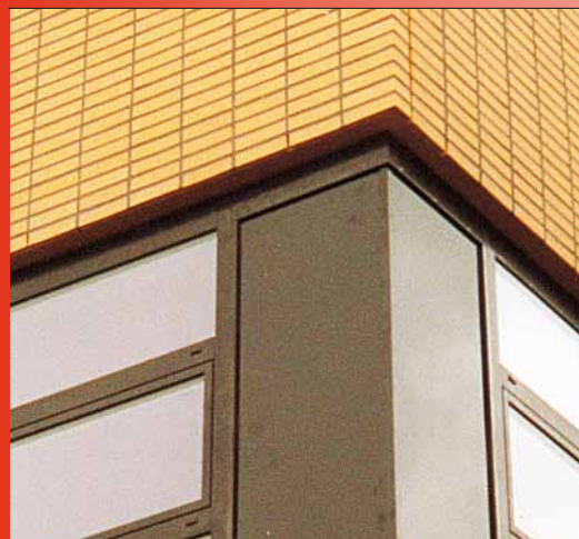
Foto 3: Geëmailleerde GBP Hardglaspanelen Door een alu-hoekstrip in het paneel op te nemen.
