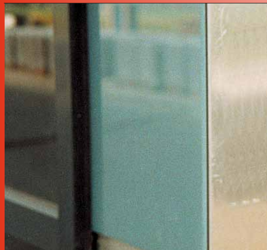
Foto 2: Geëmailleerde GBP Hardglaspanelen Door een sandwich-GBP achterpaneel te nemen in de vorm van een hoekpaneel en daarop in de bouw de ruiten te verlijmen met gevelplaat rillenkit.
