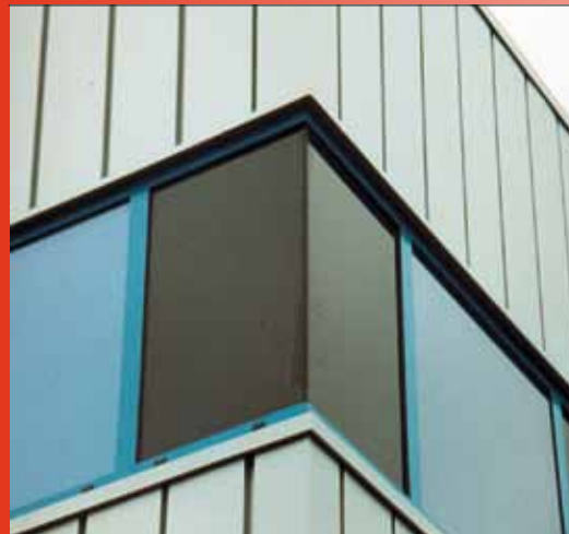
Foto 1: Geëmailleerde GBP Hardglaspanelen Door twee vlakke panelen op de bouw samen te voegen tot een hoekpaneel.
