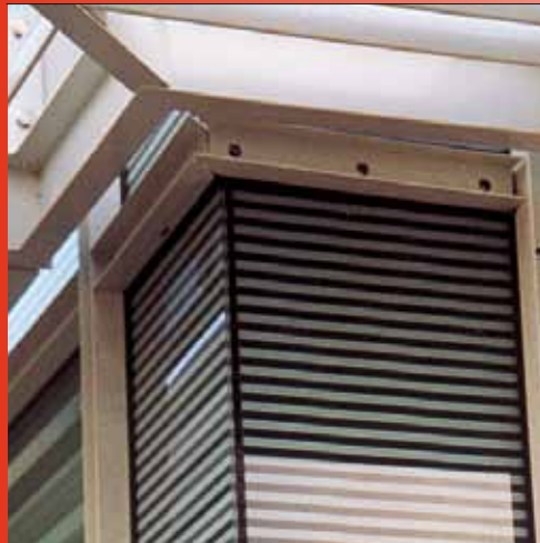
Foto 5: Gezeefdrukte GBP Hardglaspanelen Door een compleet GBP Hardglas sandwich hoekpaneel toe te passen.
