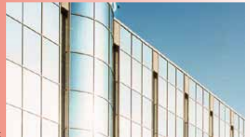
Foto 1: Geëmailleerde GBP Hardglaspanelen Door twee vlakke panelen op de bouw samen te voegen tot een hoekpaneel.
